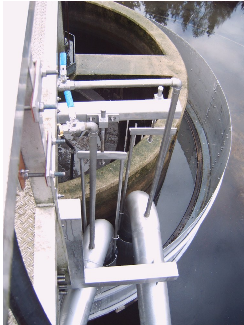
Heberrohre mit Evakuierungsanschluss und Regeltöpfe
